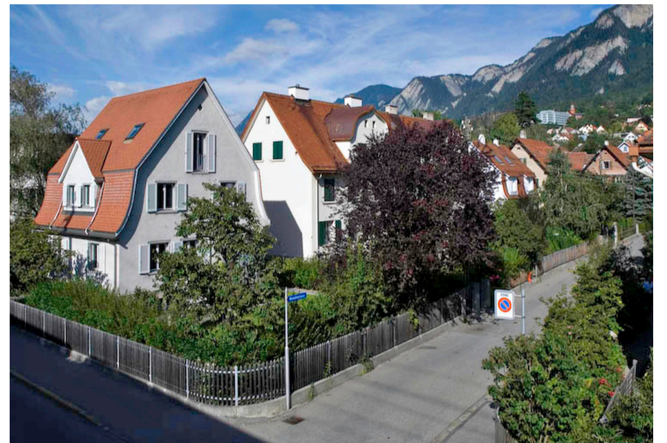
Dunkle Solarzellen würden in der Dachlandschaft der Siedlung Stampagarten einen Fremdkörper darstellen. Das Erscheinungsbild würde dadurch zu stark verändert. BILD: BAUKULTUR.GR.CH
